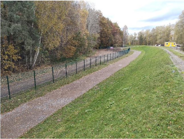
Foto 1: fertig gestellter STS Wirtschaftsweg und Zaun
